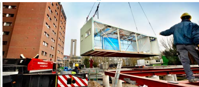
MODULAIR OPERATIE COMPLEX VU medisch centrum
