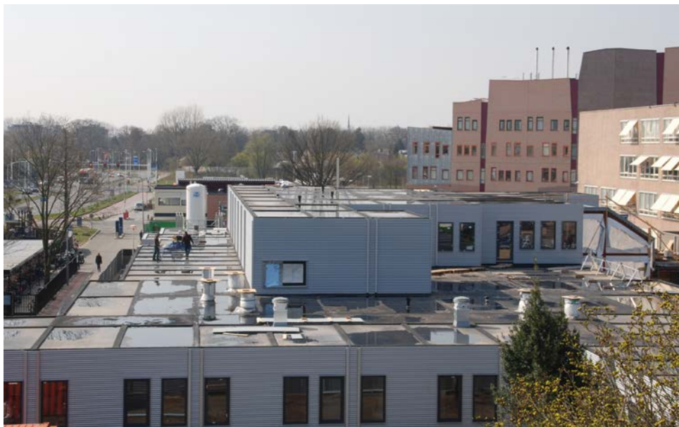
De techniek bevindt zich grotendeels in de modules op de eerste verdieping.
