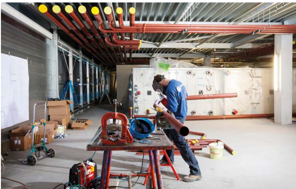
Bouw in uitvoering.
