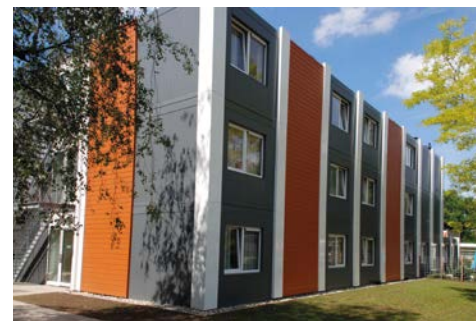
Aan de buitenzijde is bijna niet te zien dat het modulaire bouw betreft.
