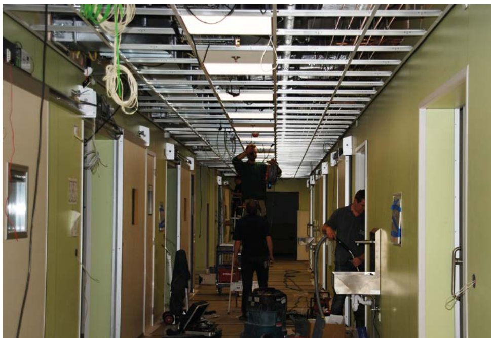
Voor het inrichten van het gebouw werkt Bussman altijd met vaste partners.
