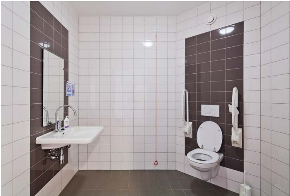
De badkamers werden ook inclusief betegeling en sanitair aangeleverd.
